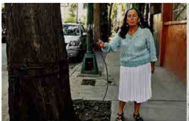
El proyecto para soterrar la red de cables llevaría al menos 2 años en la CDMX y no hacerlo pone en riesgo a peatones.
