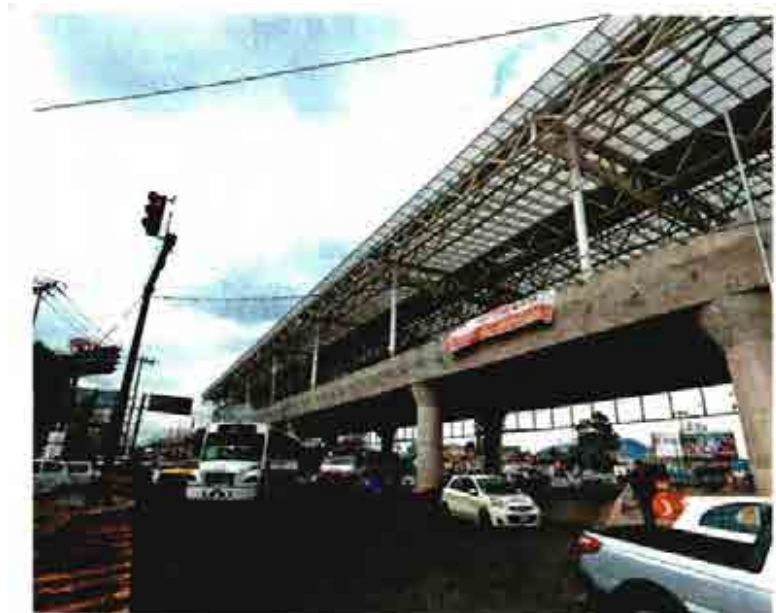
La construcción del Tren Interurbano, en la alcaldía de Cuajimalpa, en la Ciudad de México, fue la razón por la que se realizaba la red de agua.
