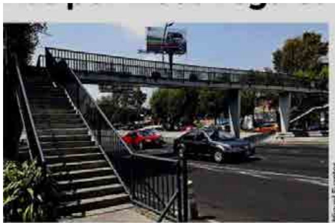
Hasta ahora, los puentes permanecen limpios en Viaducto.
