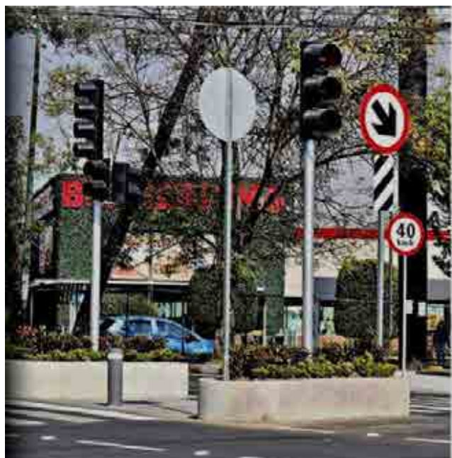
■ En las intersecciones se realizó balizamiento y colocación de bolardos. Además, de fantasmas reflejantes.
