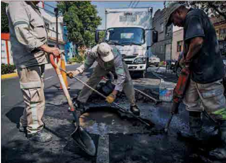
Una brigada de reparación trabaja en una fuga de agua en Ciudad de México. / SEILA MONTES
