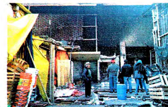
El entorno de la Nave Mayor también lucía ayer desolado con la mercancía siniestrada que era sacada del interior.
