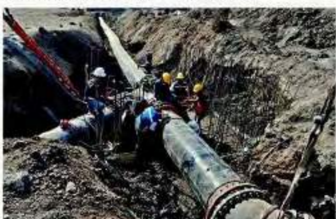
La Conagua dio mantenimiento a los acueductos Los Reyes Ferrocarril y Teoloyucan.
