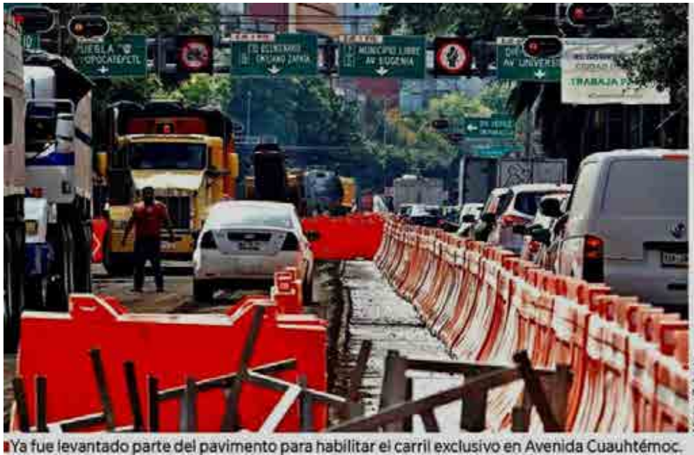
Ya fue levantado parte del pavimento para habilitar el carril exclusivo en Avenida Cuauhtémoc.
