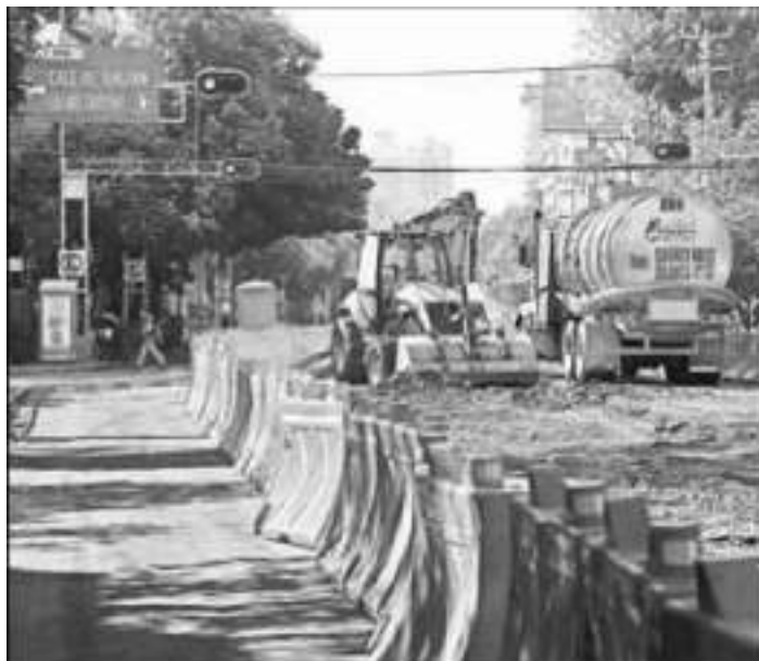
◀ Trabajos de ampliación de la línea 3 del Metrobús sobre avenida Cuauhtémoc, a la altura de Eugenia, donde desde el 15 de octubre permanecen confinados los carriles centrales, entre las estaciones Etiópia y División del Norte del Metro. Foto: Jesús Villasaca
